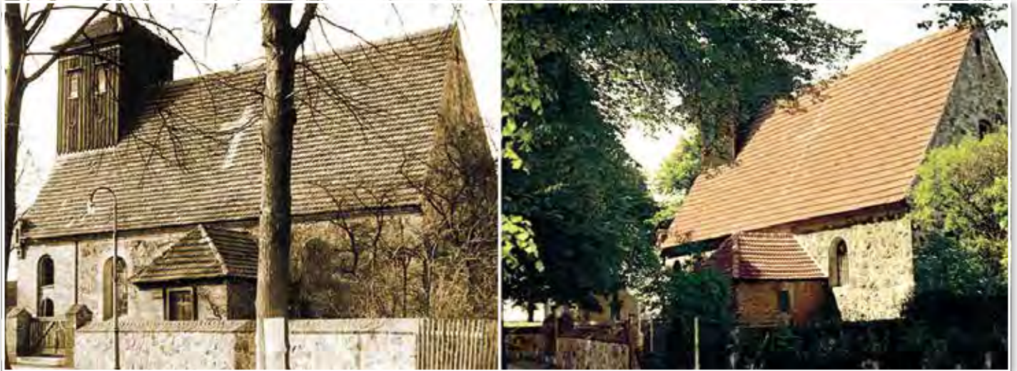
Die Veränderung des im Dach eingearbeiteten Kreuzes im Laufe der Jahre (1964 und 1975)
