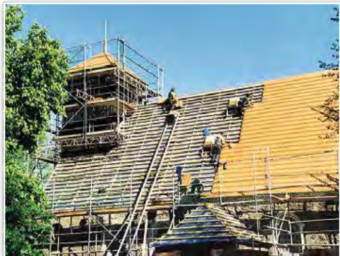
Neueindeckung des Kirchendaches
