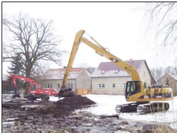
Abb. 8 Durchführung der Arbeiten zur Entschlammung des Dorfteiches Bestensee – Einsatz von Baggertechnik bei anhaltender winterlicher Frostwitterung (Februar 2006)
