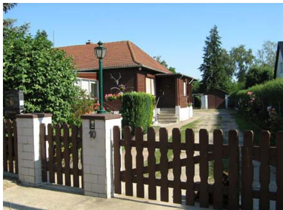
Foto 10, 11: Bebauung am Schleifweg, Nordseite
