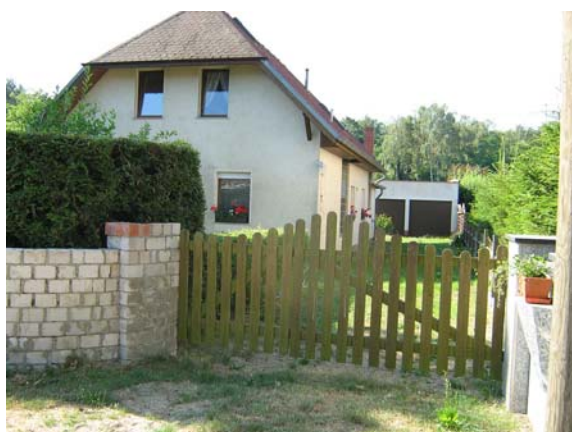
Foto 11: Bebauung am Schleifweg, Nordseite
