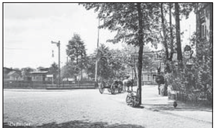
Bahnübergang Groß Besten, 1932
