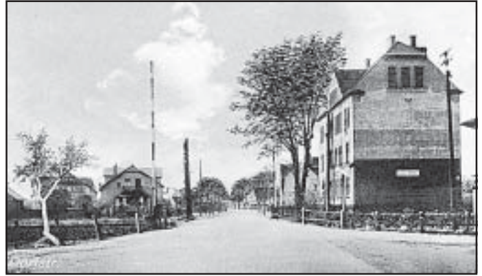
Bahnübergang Klein Besten mit dem „Wohngebäude für 6 Unterbeamte“, 1932
