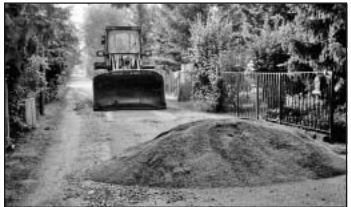
Schwere Technik im Einsatz
