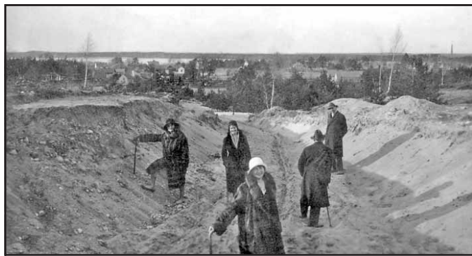
Begutachtung des Straßenbaufortschritts Am Hang durch die Pätzer „High society“
