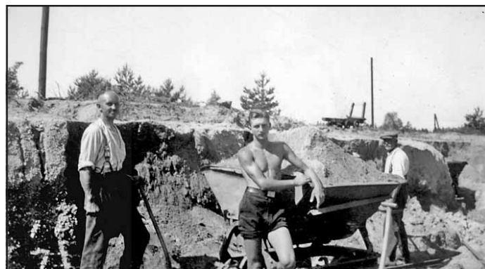
Erdreich-Abtragung beim Straßenbau
