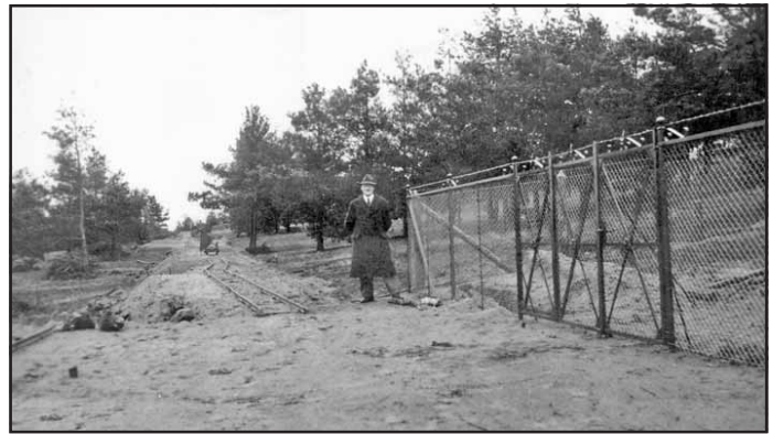
Straßenbau Am Hang vor Zebitz
