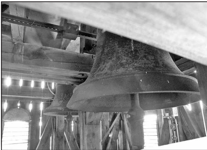
Blick in den Glockenstuhl der Dorfkirche
