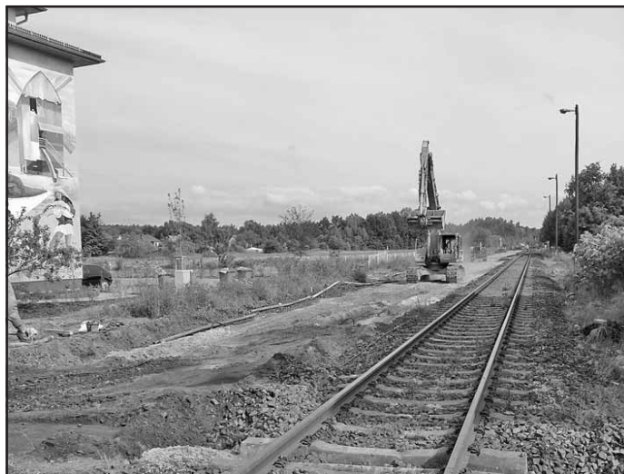
Mitte Juni: Das 2. Gleis ist abgebaut
