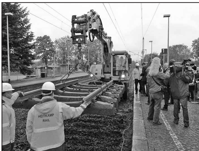
Durchtrennen der Gleise
