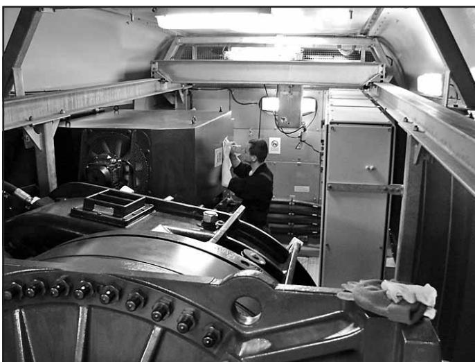
Blick in den Maschinen- und Schaltraum
