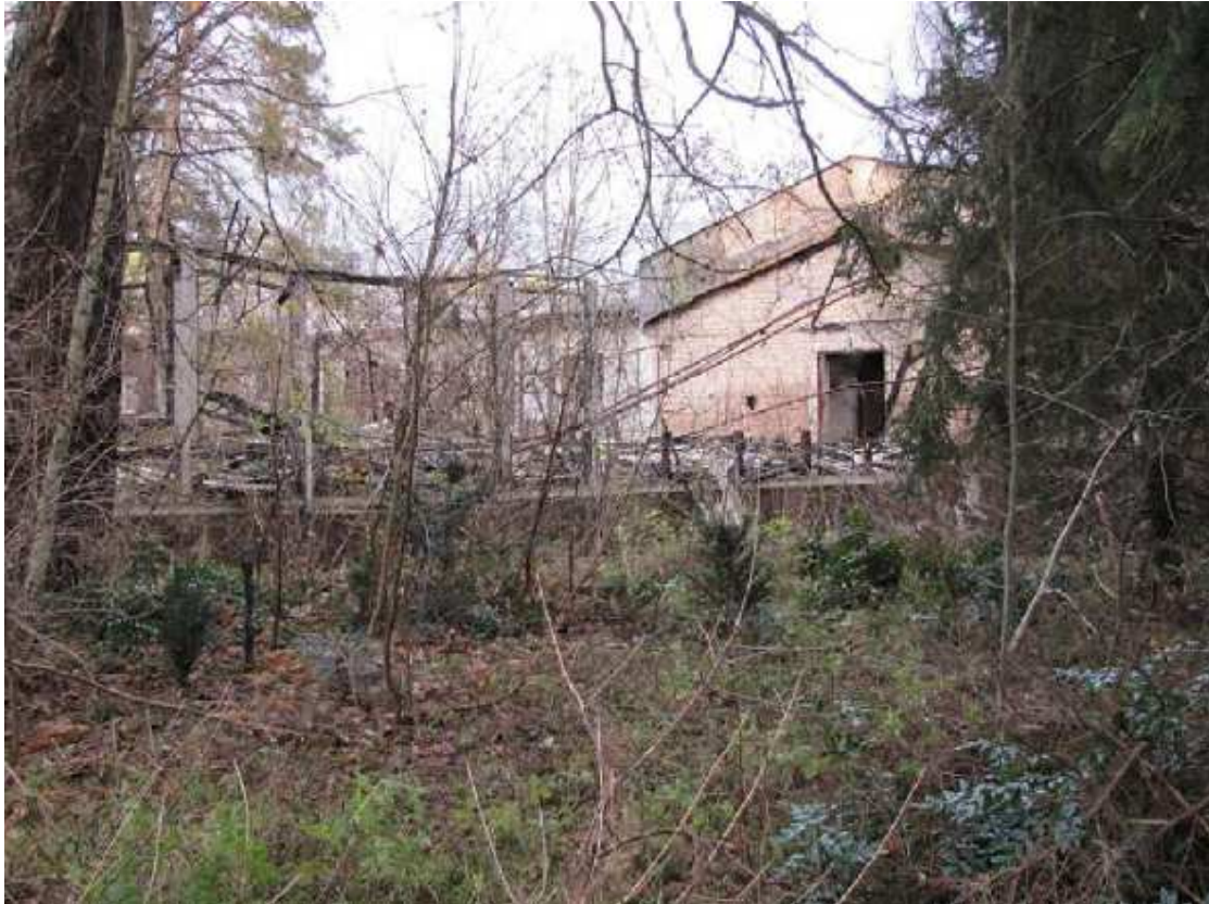
Brandruine - ehemaliges Erholungsobjekt
