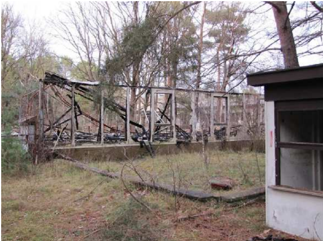
Brandruine - ehemaliges Erholungsobjekt
