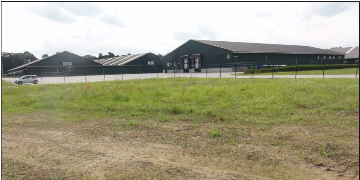
Abbildung 1: Eingriffsfläche, vorhandenes Betriebsgelände im Osten der Betriebsbereiches L-11, IBE-Ingenieurbüro Dr. Eckhof GmbH, August 2017
