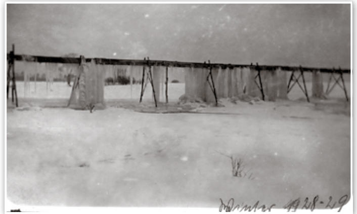
Entwässerungsleitung Pätzer Tongrube
