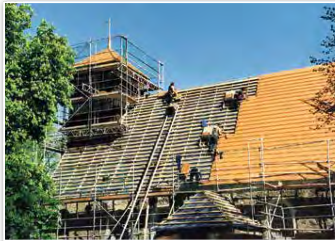
Neueindeckung des Kirchendachs 2002
